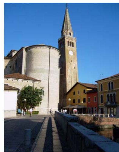
Duomo di S. Andrea (abside e campanile)
